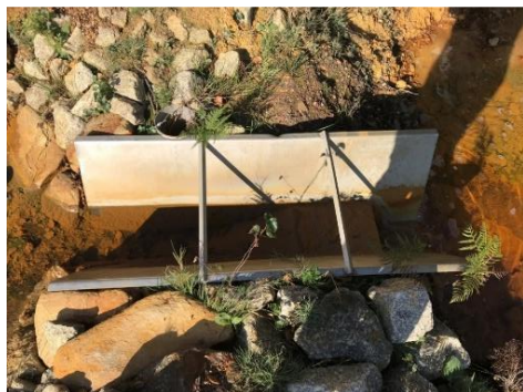
Fig. 3. Aforador tipo RBC instalado aguas abajo del terraplén.
