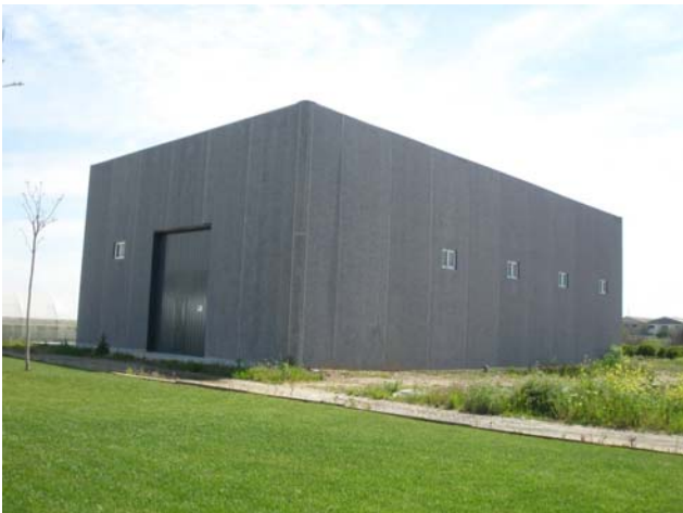
Fig. 4. Nave que alberga la infraestructura
