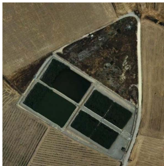
Fig. 3. Vista aérea de la EDAR de Verdú
