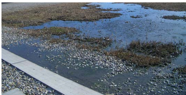
Fig. 2. Flujo superficial en el humedal artificial de Verdú como consecuencia de la colmatación ( clogging ) de la capa de grava
